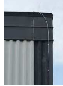
Lightning Downconductor 25 x 3 mm Cu or Al Tape
