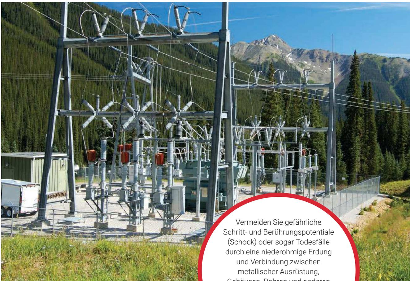
Vermeiden Sie gefährliche Schritt- und Berührungspotentiale (Schock) oder sogar Todesfälle durch eine niederohmige Erdung und Verbindung zwischen metallischer Ausrüstung, Gehäusen, Rohren und anderen leitenden Objekten, sodass Stromstöße aufgrund von Fehlern nicht zu gefährlichen Spannungsanstiegen führen.
