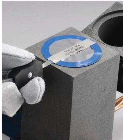
**Schritt 2:** Fügen Sie das Cadweld Plus-Schweißmaterial hinzu.
