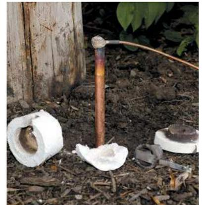
1. Nachdem Sie den Tiefenerder und den Erdleiter vorbereitet haben, positionieren Sie den Cadweld One Shot und befestigen das Kabel an der Steuereinheit.
