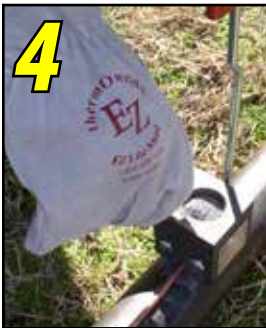
4 Pour weld metal into mold.
