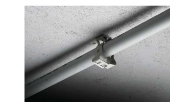
Kabelschutzrohr auf Beton
