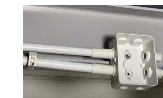
Kabelschutzrohre und Verteilerdosen abgehängt von Trägern
