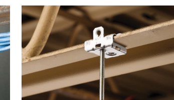
Gewindestange/Kette/Draht abgehängt von Trägern
