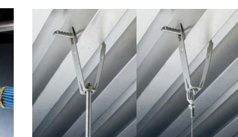
Gewindestange/Kette/Draht abgehängt von trapezförmigen Stahldecken
