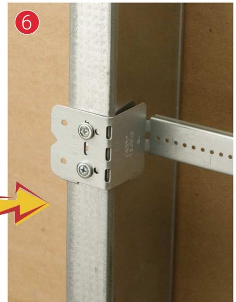
6. Installer la fixation TSGB sur les montants avec les petites vis article no. 187197.
