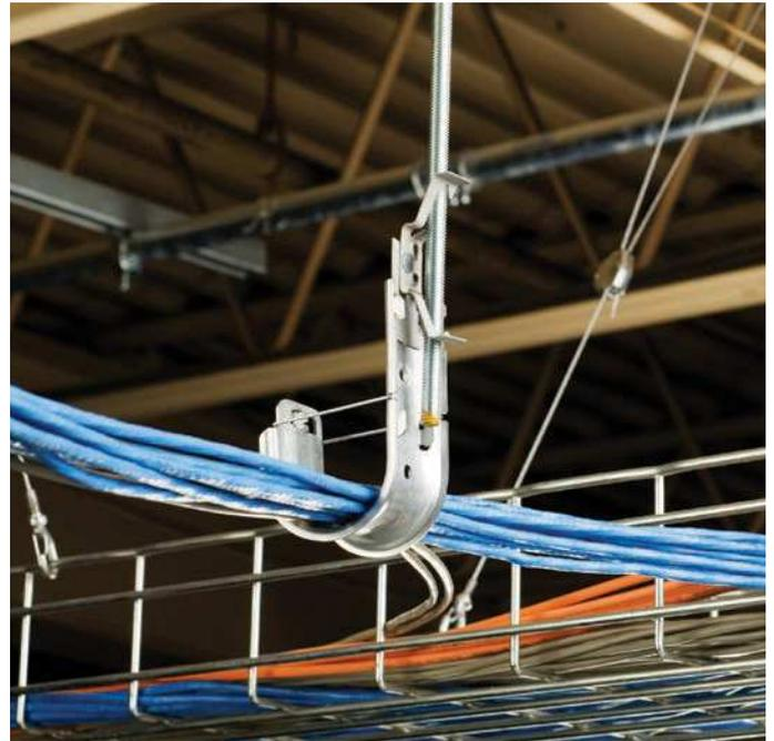
Der nVent CADDY Cat HP J-Haken trägt und hält Kabel ohne die Notwendigkeit von Bündelung für den Erhalt der Kabelquantität und der Qualität der Kabelseparation.
