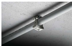
Kabelschutzrohr auf Beton
