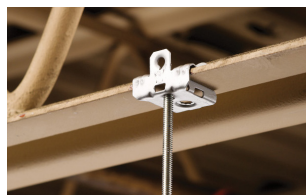
Gewindestange/Kette/Draht abgehängt von Trägern
