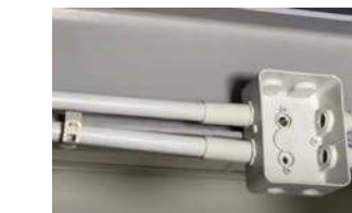
Conduits et boîtier électrique sur poutre acier
