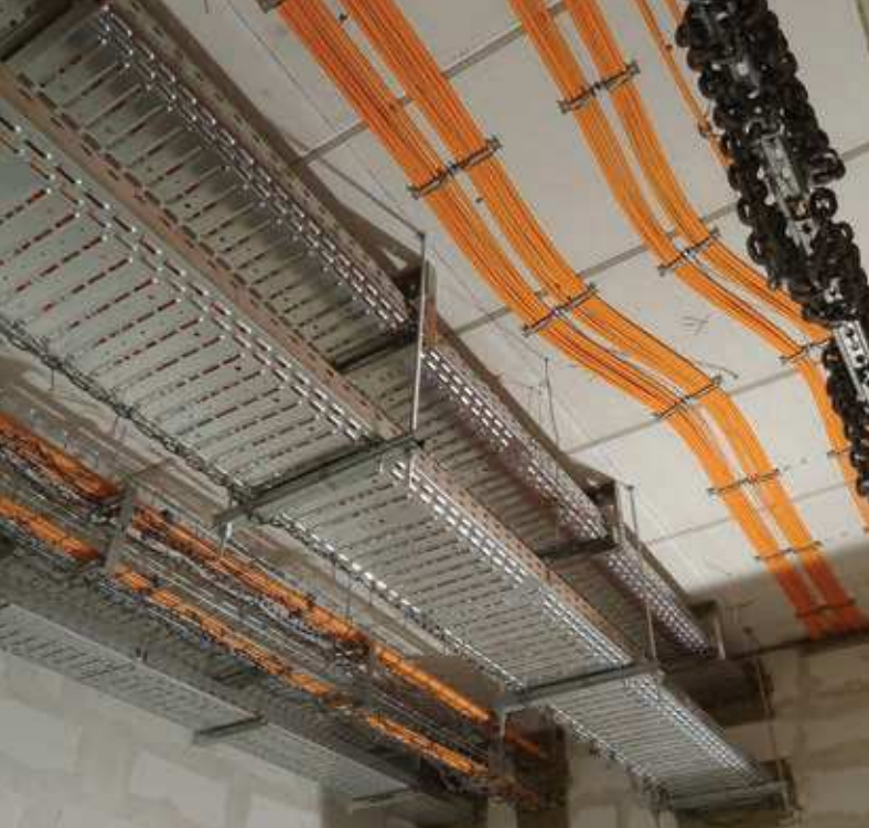
Bilder vom Brandversuch für UTS, PKM, CT & Teleskopische Montageschiene mit Rod Lock vor der Durchführung
