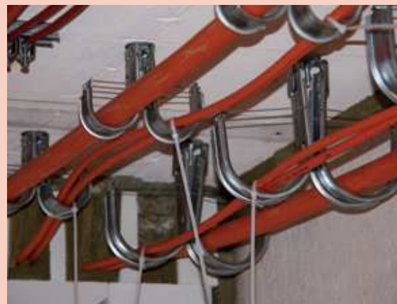
J-Haken und Kabel in Brandkammer vor Brandversuch
