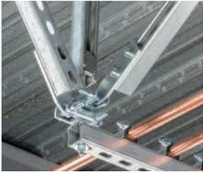
Erbebenaussteifung Trapeze, Strut Montageschienen
