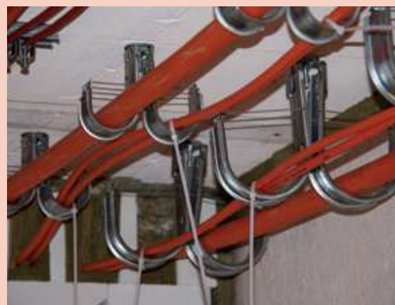
J-Haken und Kabel in Brandkammer vor Brandversuch
