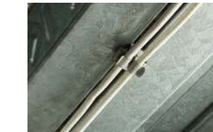
Cables & conduits from metal deck
