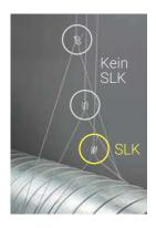
Das SLK-Schloss hält einen Ausbreitungswinkel des Drahtseils von bis zu 90 Grad aus. Das bedeutet, dass das Gerät näher an breite Anlagen montiert werden kann, wie z.B. Rundrohre, so dass die Schloss nicht sichtbar ist und eine kompaktere, ästhetisch ansprechendere Installation möglich wird.
