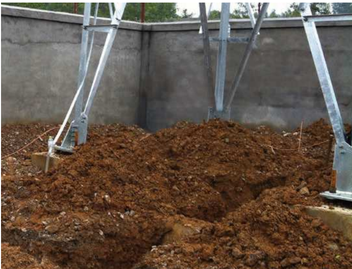
Erdung des Telekommunikationsturms
