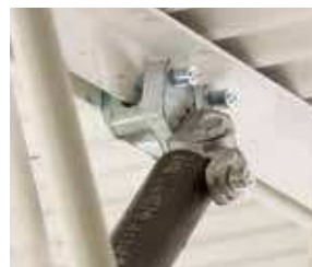
Fixation structurelle universelle CSBUNIVxxxEG - p. 18
