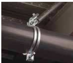
Renfort parasismique universel pour tuyau CSBxxxx – p. 21
