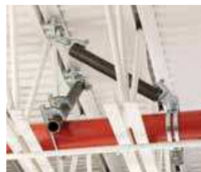
Fixation pour poutrelle CSBBARJEG - p. 14
