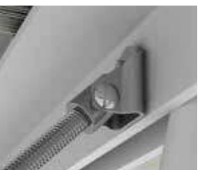
Fixation structurelle de retenue pour canalisation secondaire sur acier CSBBS1MEG - p. 37
