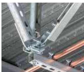
Renfort parasismique par profil de montage, pour trapèze CSBR2 – p. 28
