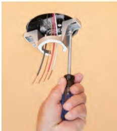
4 Install fan bracket
