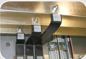
nVent ERIFLEX Flexibar est certifié conducteur isolé classe II (CEI 61439-1 chapitre 8.4.4 Protection par une isolation totale) et peut être utilisé comme conducteur de puissance entre appareillages et ou comme jeu de barres, tandis que la plupart des autres conducteurs utilisant une isolation basique, ne doivent pas être en contact avec des pièces sous tension, de différence de potentiel.
