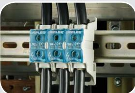
Les blocs de jonction et borniers de puissance nVent ERIFLEX sont testés et certifiés selon la CEI 60947-7, et ont une résistance aux courants de court-circuit très élevée.
