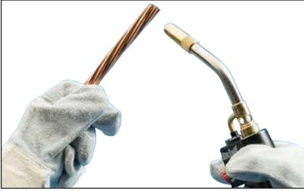
**Fig. 11** – Les conducteurs doivent être propres et secs avant d'effectuer la connexion. Utiliser un chalumeau au propane pour sécher les conducteurs métalliques et éliminer les résidus de nettoyage restants, le solvant ou l'eau avant d'effectuer la connexion Cadweld.
