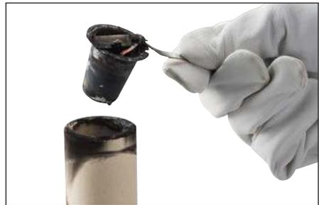
**Fig. 14** – Retirez et jetez la coupelle métallique soudée Cadweld Plus usagée.
