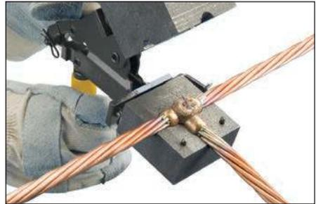
**Fig. 25** – Ouvrir le moule et désactiver la connexion. Prendre des précautions pour éviter de broyer le moule. Éviter tout contact avec des matériaux chauds. Voir la section « Normes de qualité nVent ERICO Cadweld » pour voir si une connexion de qualité a été établie.
