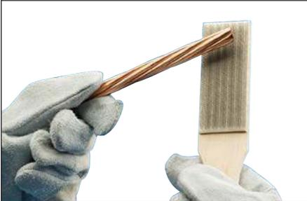
**Fig. 12** – Ensuite, utiliser une brosse métallique pour préparer davantage la surface des conducteurs (brosse nVent ERICO T-313 ou T-314). Gratter la surface extérieure pour éliminer la saleté et l'oxydation. Vous remarquerez un léger changement de couleur.
