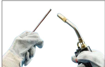
**Fig. 4** – Les conducteurs doivent être propres et secs avant d'effectuer la connexion. Utiliser un chalumeau au propane pour sécher les conducteurs métalliques et éliminer les résidus de nettoyage restants, le solvant ou l'eau avant d'effectuer la connexion Cadweld.
