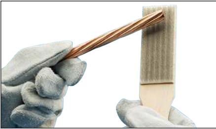
**Fig. 12** – Ensuite, utiliser une brosse métallique pour préparer davantage la surface des conducteurs (brosse nVent ERICO T-313 ou T-314). Gratter la surface extérieure pour éliminer la saleté et l'oxydation. Vous remarquerez un léger changement de couleur.
