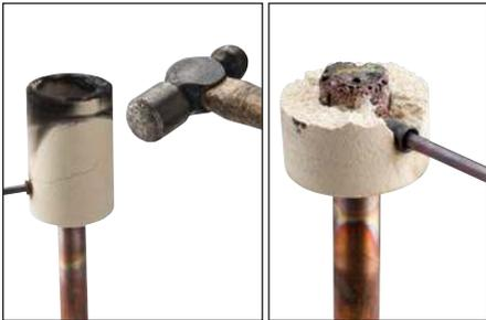
**Fig. 15** – Déconnectez le moule Cadweld One Shot en céramique de la connexion. Éviter tout contact avec des matériaux chauds. Voir la section « Normes de qualité nVent ERICO Cadweld » pour voir si une connexion de qualité a été établie.
