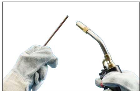
**Fig. 4** – Les conducteurs doivent être propres et secs avant d'effectuer la connexion. Utiliser un chalumeau au propane pour sécher les conducteurs métalliques et éliminer les résidus de nettoyage restants, le solvant ou l'eau avant d'effectuer la connexion Cadweld One Shot.
