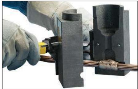
**Fig. 28** – Ouvrir le moule et désactiver la connexion. Prendre des précautions pour éviter de broyer le moule. Éviter tout contact avec des matériaux chauds. Voir la section « Normes de qualité Cadweld » pour voir si une connexion de qualité a été établie.
