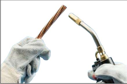
**Fig. 11** – Les conducteurs doivent être propres et secs avant d'effectuer la connexion. Utiliser un chalumeau au propane pour sécher les conducteurs métalliques et éliminer les résidus de nettoyage restants, le solvant ou l'eau avant d'effectuer la connexion Cadweld.
