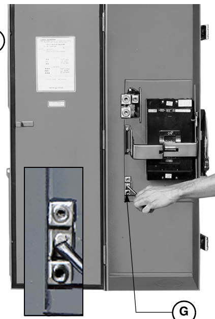
Install Ground Lugs / Instalación de las zapatas de tierra / Installation des cosses de m.à.t.
