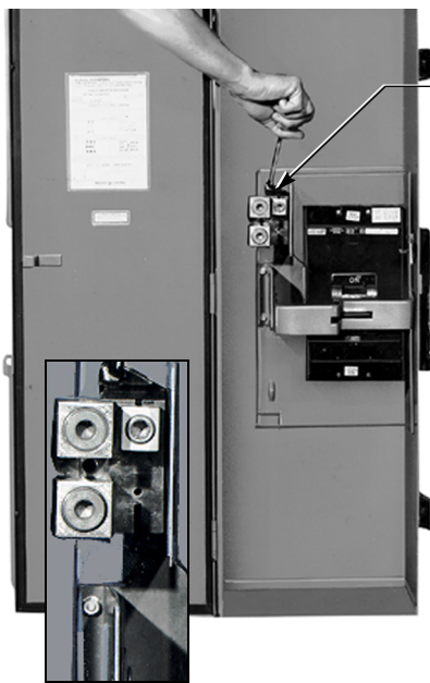
Install Neutral Assembly / Instalación del ensamble de neutro / Installation de l'ensemble du neutre
