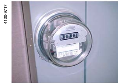
Fig. 8: Meter and Meter Cover Reinstalled / Medidor y cubierta del medidor instalados
