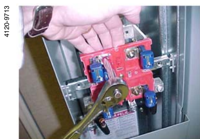
Fig. 4: Line Side Meter Jaws / Mordazas del medidor del lado de línea
