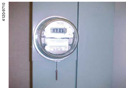
Fig. 1: Combination Service Entrance Device with Meter Cover and Meter / Base integral de medición para acometida con medidor y cubierta del medidor
